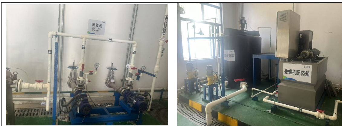
现有已建污水处理站
