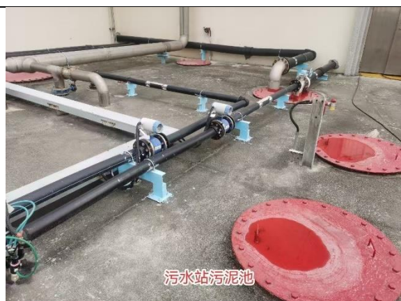
污水站污泥池
