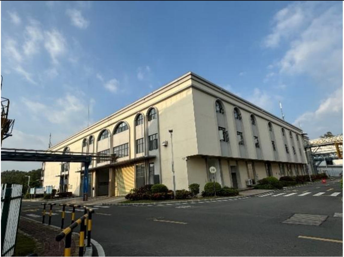
污泥干化车间（厂区地面已硬化）
