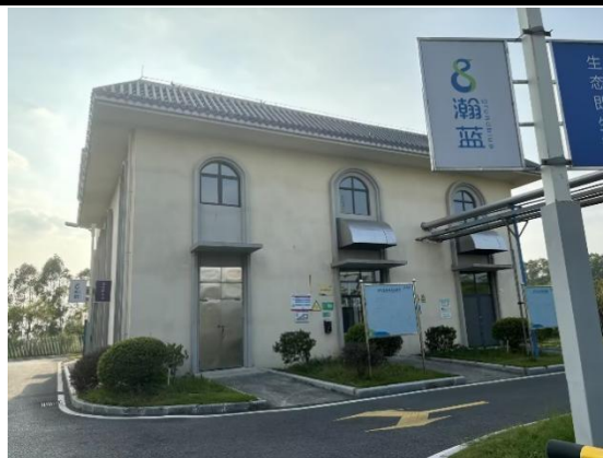
沼气发电机房
