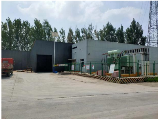
升压站南侧飞灰库
