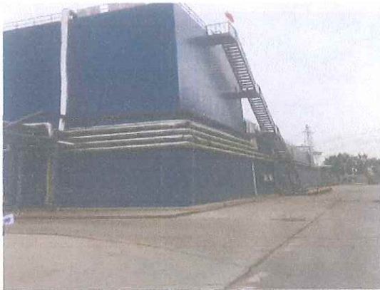
厌氧、消化反应区池
