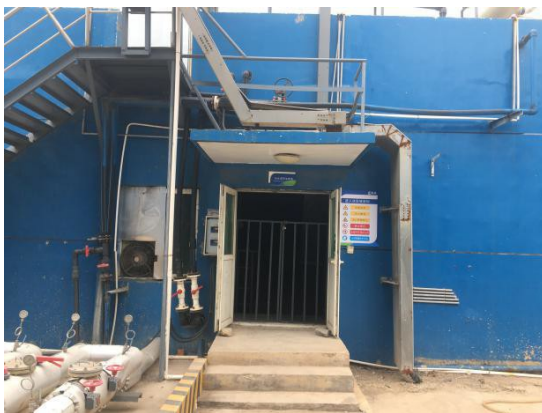
调节池池体地上，地下为泵房
