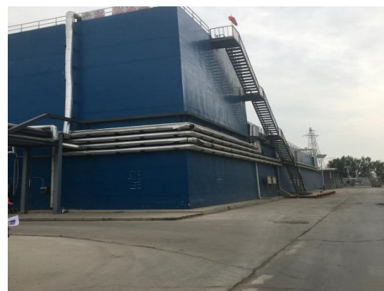
厌氧、消化反应区池体地上
