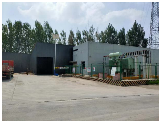
升压站南侧飞灰库
