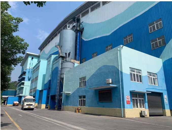
锅炉环保处理车间
