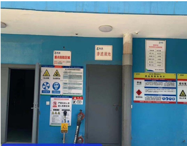
渗滤液收集池
