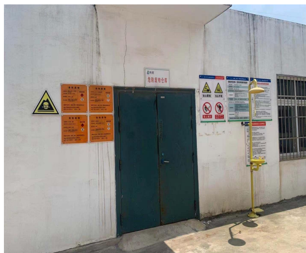
危险废物暂存间
