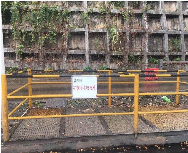
初期雨水收集池
