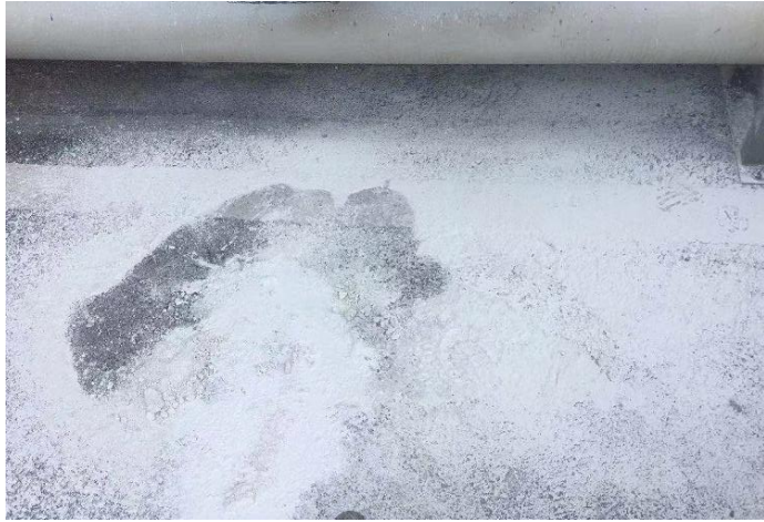
石灰仓库卸料口
