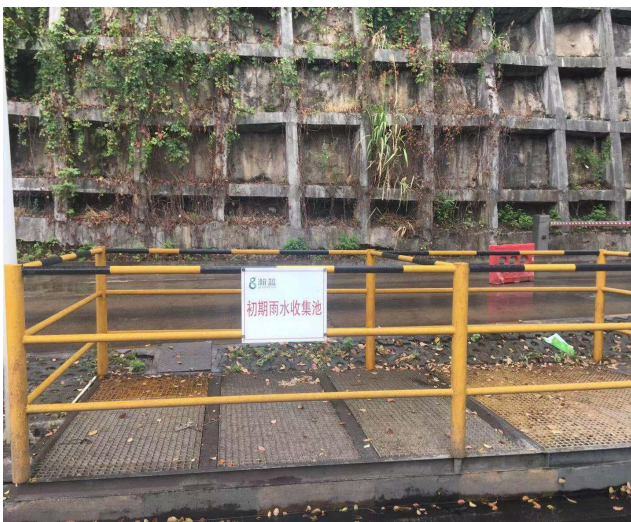
初期雨水收集池
