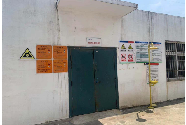
危险废弃物暂存间（外）
