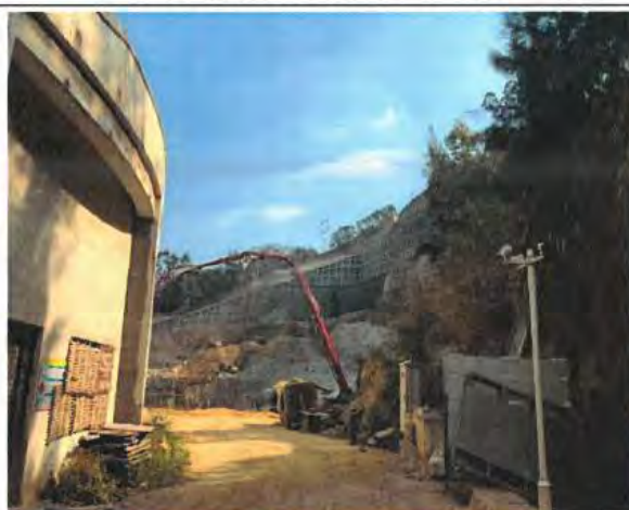
厂区东南侧施工建设中（挡墙和护坡工程）
