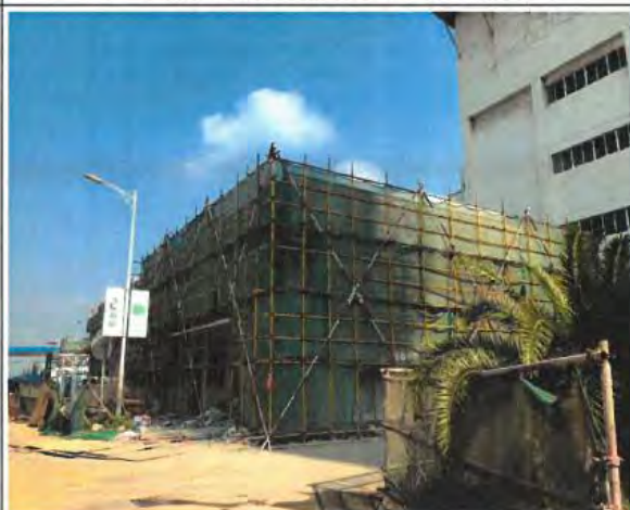
新建建筑建设中 (一期工业锅炉房西北侧原绿地)
