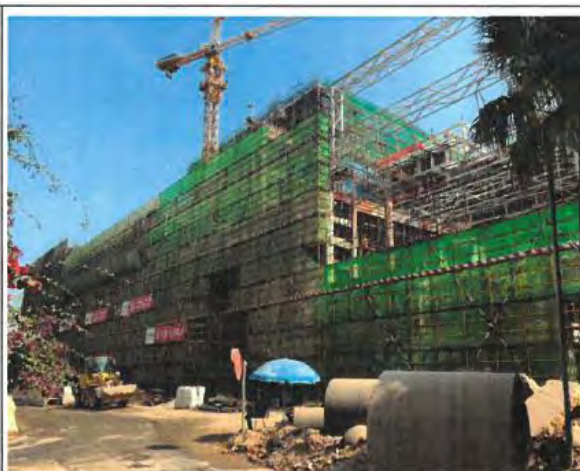
厂区东侧施工建设中（三期）
