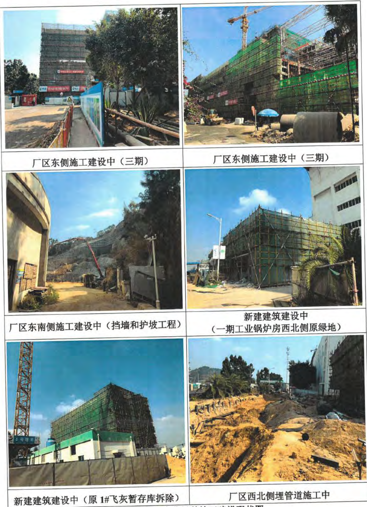
图 3-4 企业目前施工建设现状图
