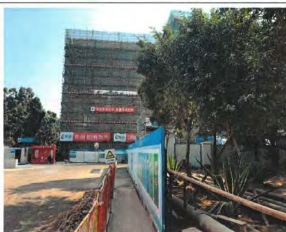
厂区东侧施工建设中(三期)
