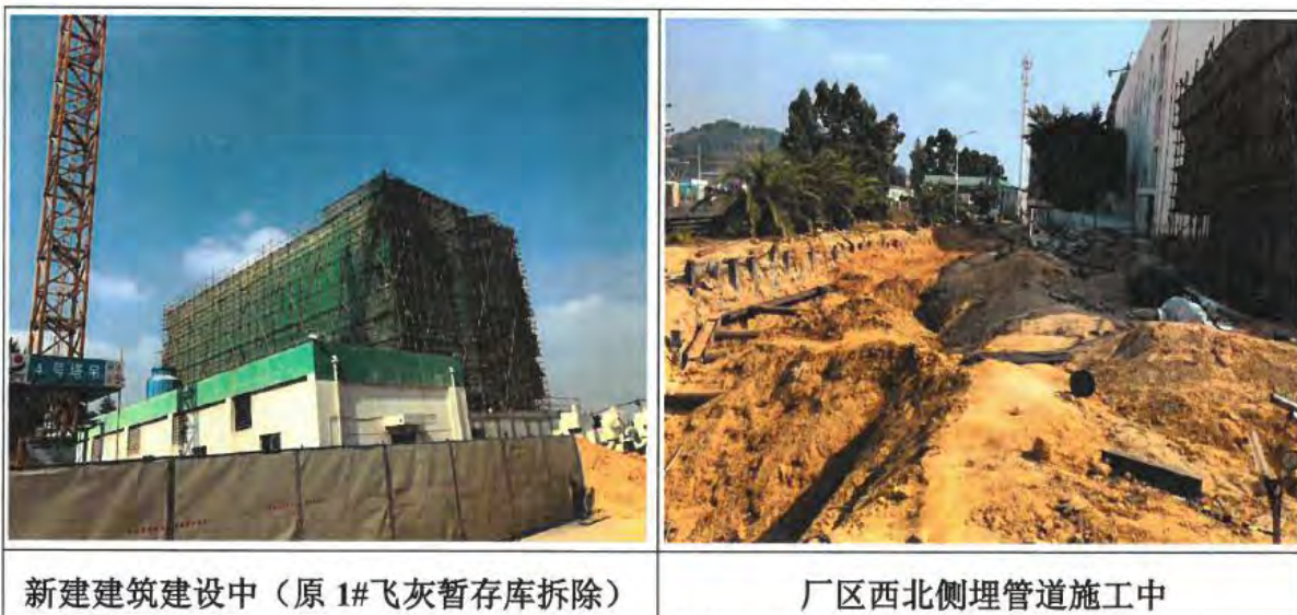
图 2-8 企业目前施工建设现状图
