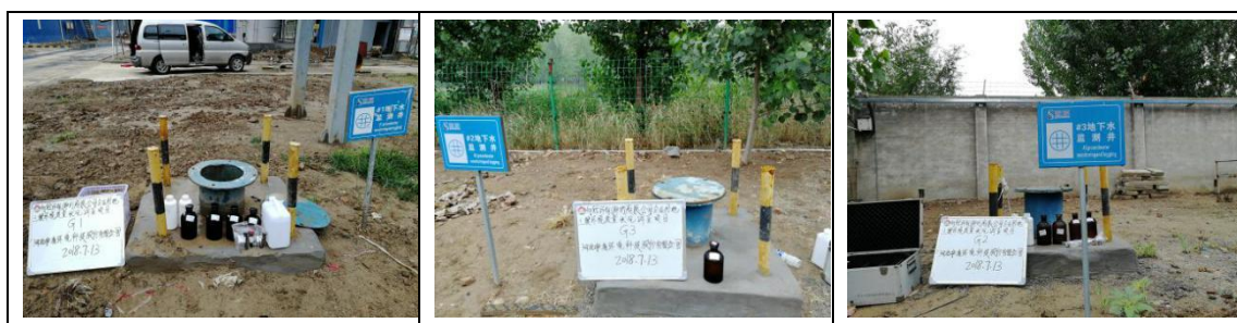
图 5.3-1 新建地下水环保监测井现场照片
